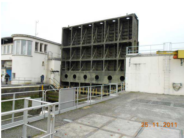
Vue d'une porte levante de l'écluse de Vogelgrun
